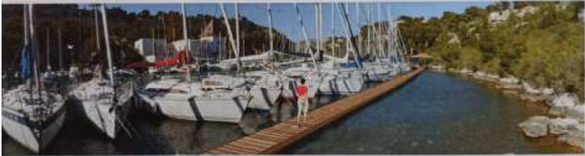
Figure 44 : Vue du ponton existant (en haut) et photomontage du ponton flottant projeté (en bas)
